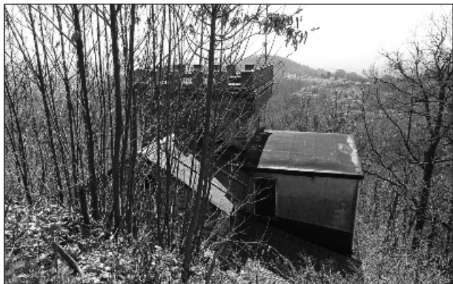
Torre vasca di carico
