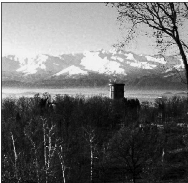
Viverone - Serbatoio piezometrico
